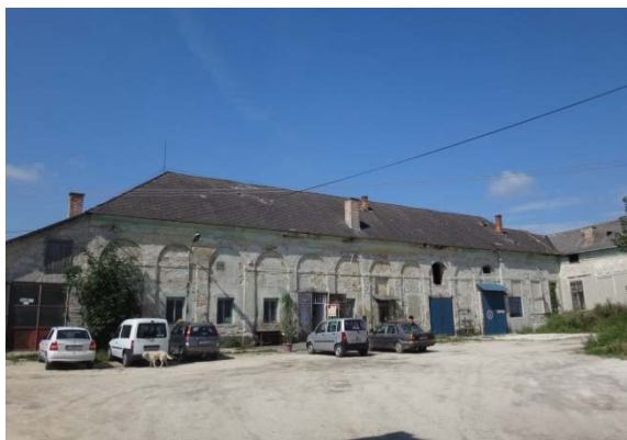
1. fotó: Az épület déli szárnyában elhelyezkedő csarnoktér keleti homlokzata, a narancsházakra jellemző magas nyílások itt feltehetően a korábbi istálló nyílásai voltak.
