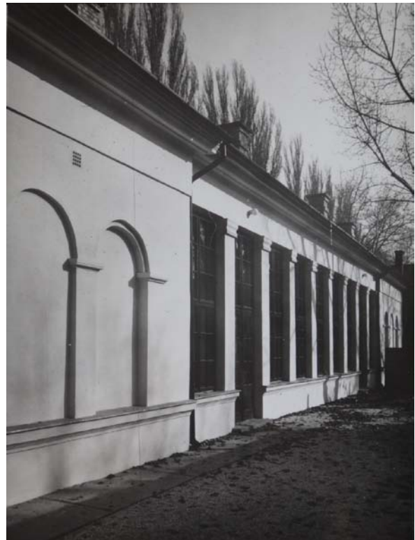
53. ábra A kastély-együttes É-i mellékudvara. Archív fénykép, FK Fotótár 115964
