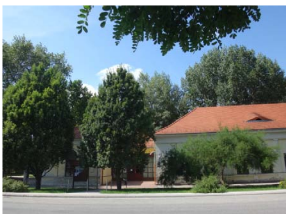
25. fotó: Az általános iskola bejárata a szentháromság tér felől
